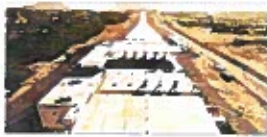
Construcción del Libramiento Obregon
