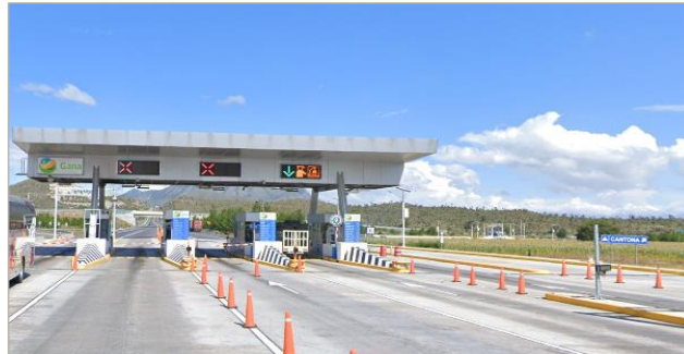
Caseta de Cobro en Amozoc-Perote, carretera 140D
