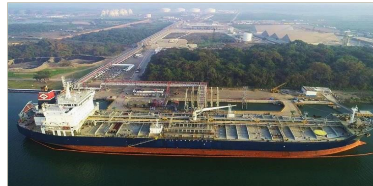
Buque descargando combustible en Terminal Itzoil
